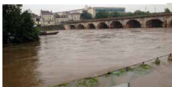
Commune de Châtelleraut, débordement de la Vienne, 2016. © EPTB Vienne
